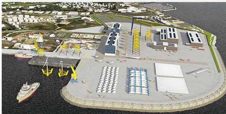
Travaux en cours pour la réalisation d'un polder sur le port de Brest visant à attirer les activités liées aux énergies marines
